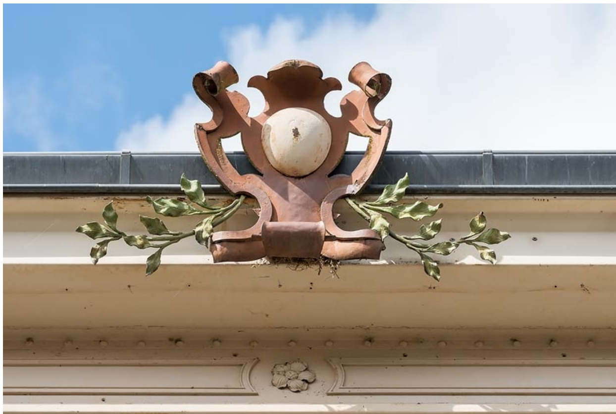
Aile ouest, salle à manger, détail.
