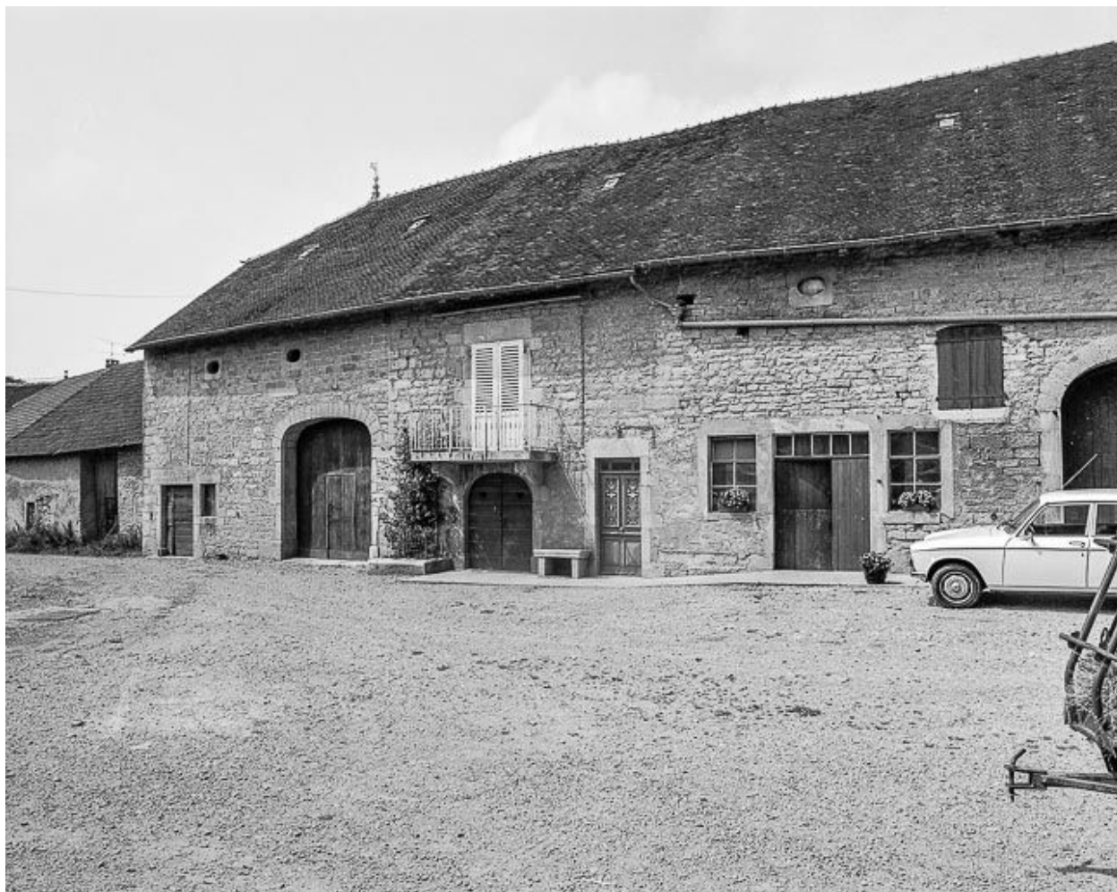
Ferme située 169 rue Saint-Néron.
