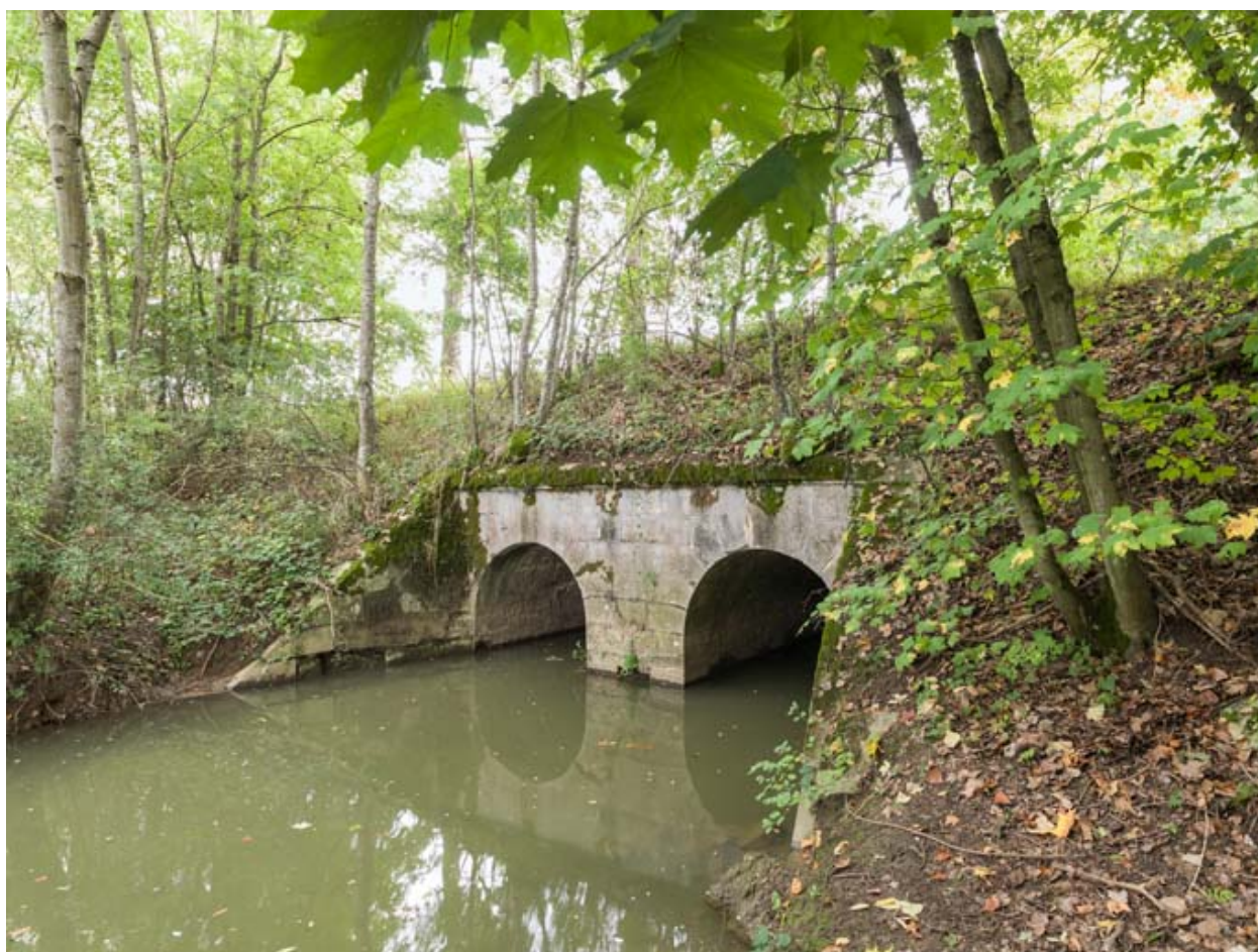
Vue de l'aqueduc.
