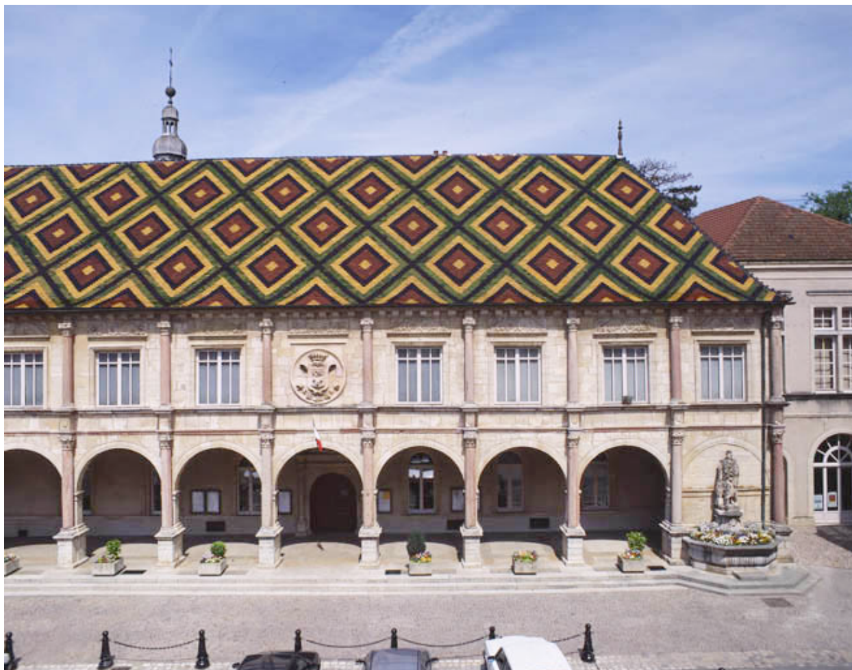
Façade antérieure vue de face : partie droite.
