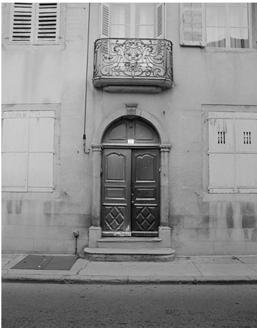
Façade antérieure, porte d'entrée et balcon.
