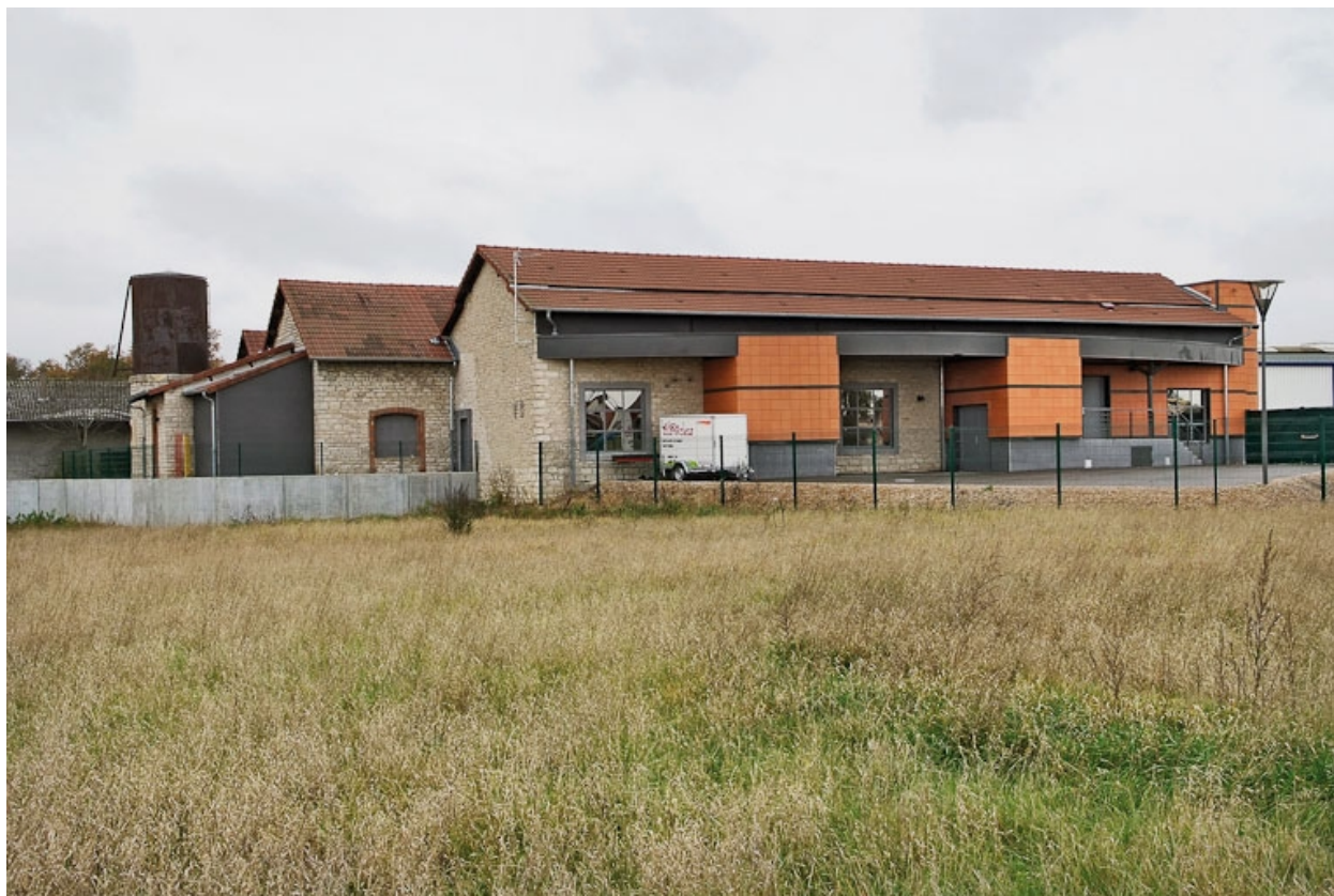
Vue d'ensemble du bâtiment.
