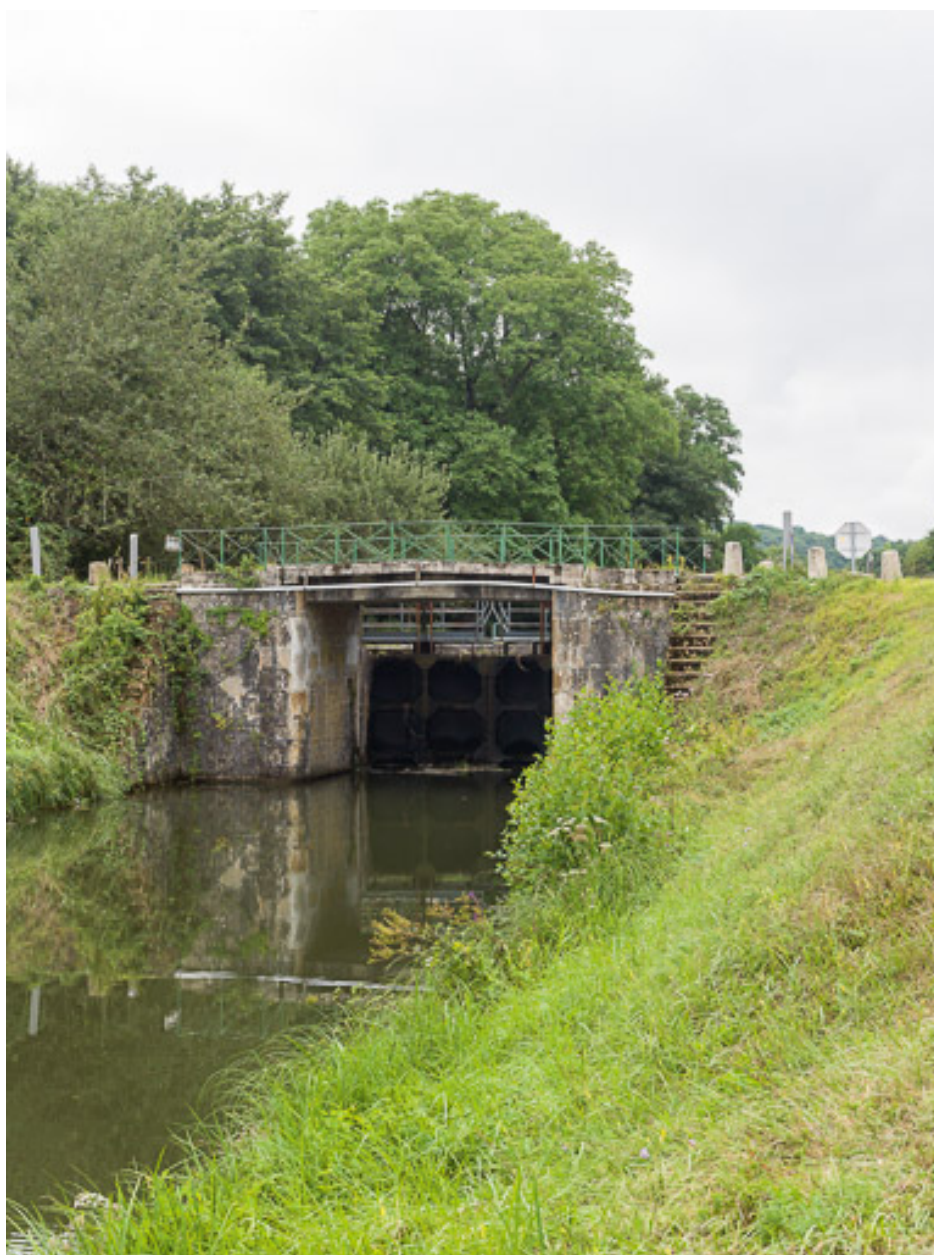
Vue d'ensemble du pont.
