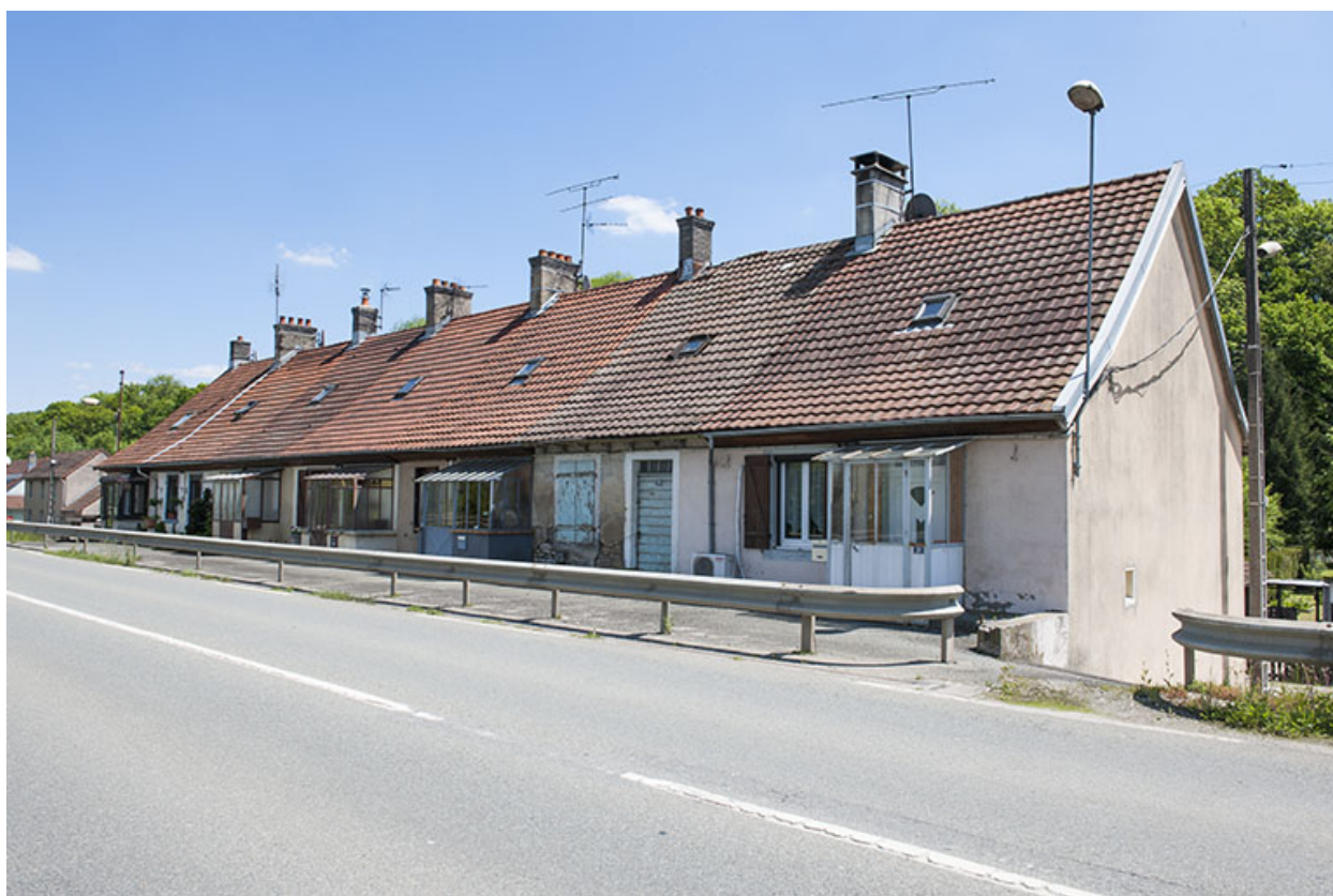
Habitation de type caserne. Vue depuis l'ouest.
