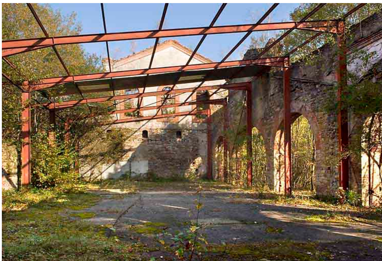
Salle des chaudières.
