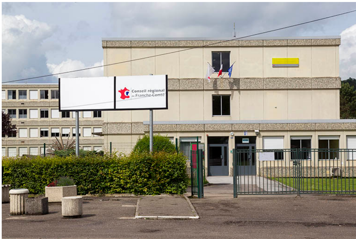
Entrée principale, façade est de l'administration.
