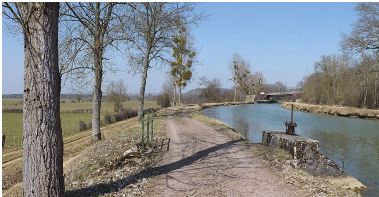
Le déversoir rive gauche dans son environnement.
