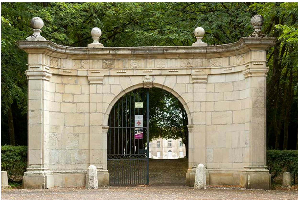
Portail à l'entrée du parc.
