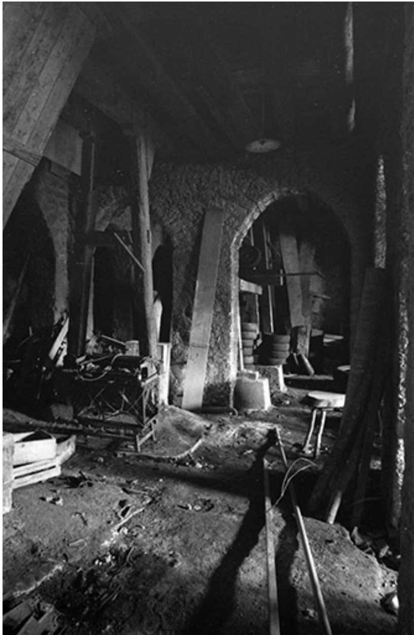
Etage de soubassement des ateliers de fabrication.
