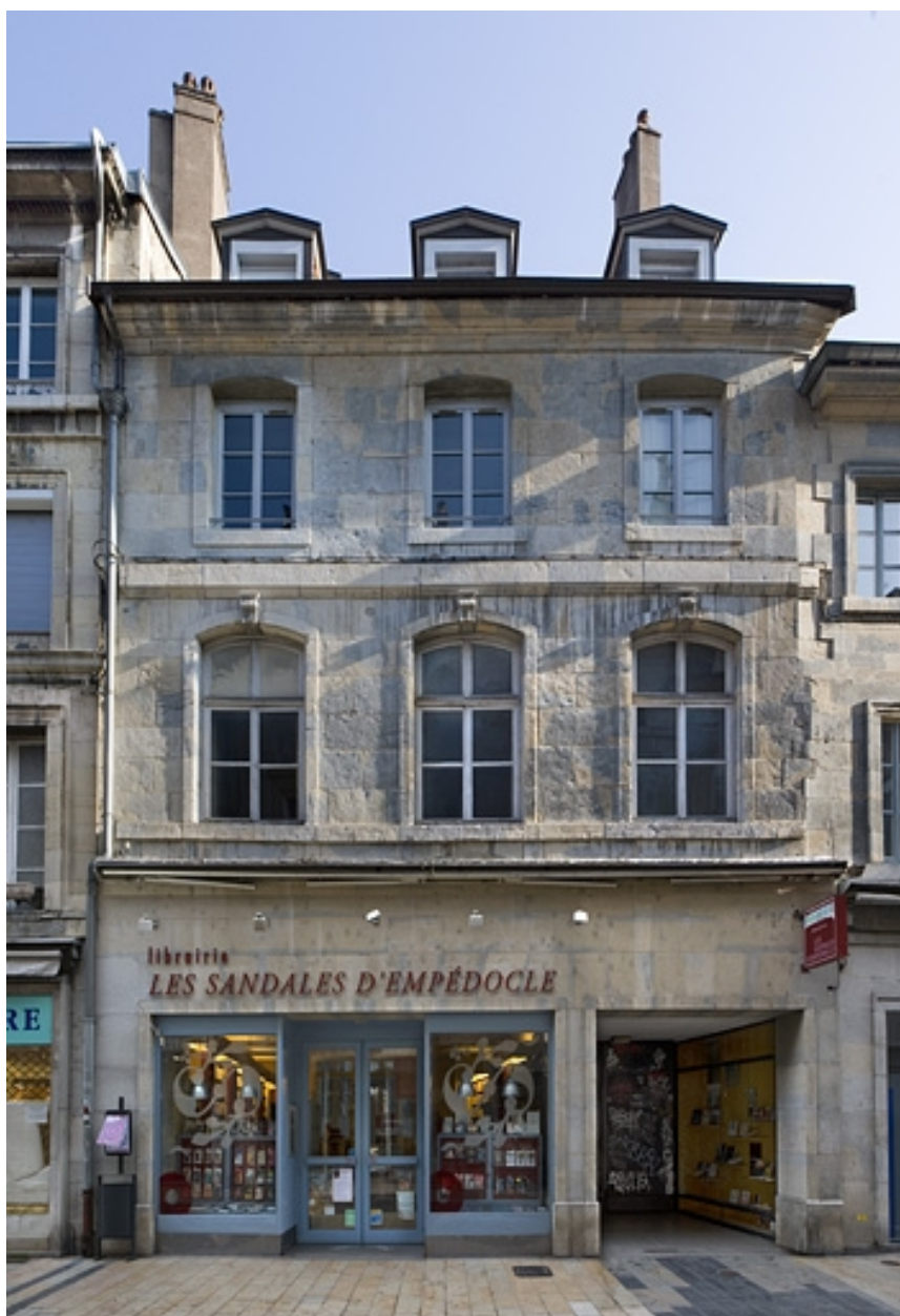
Façade sur rue : de face.
