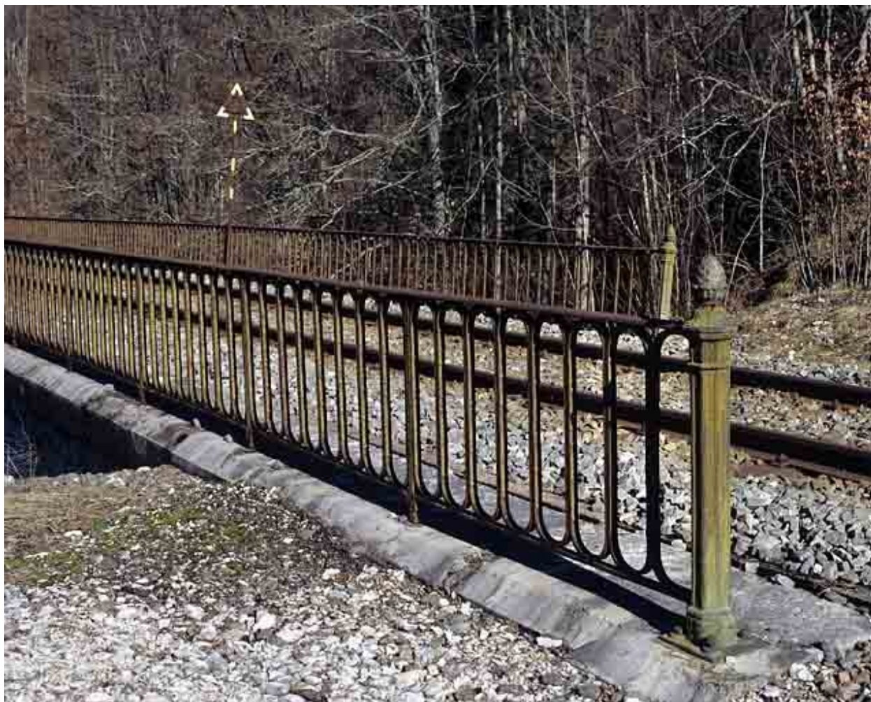
Extrémité du garde-corps métallique.
