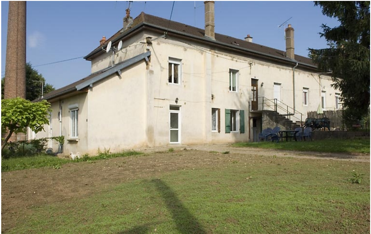
Cheminée, salle des machines et ancien atelier.
