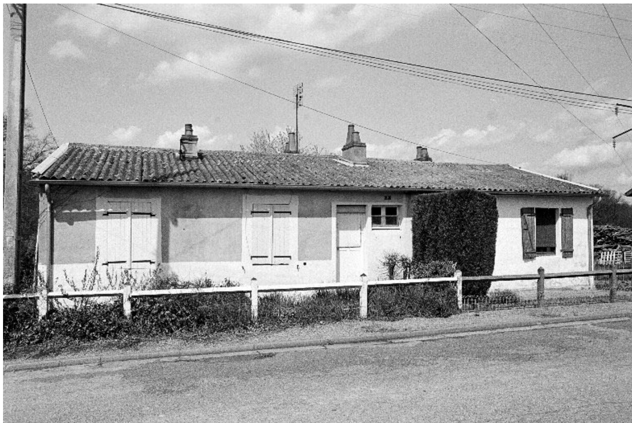
Bâtiment à 3 logements " type R ", 1939-1945.
