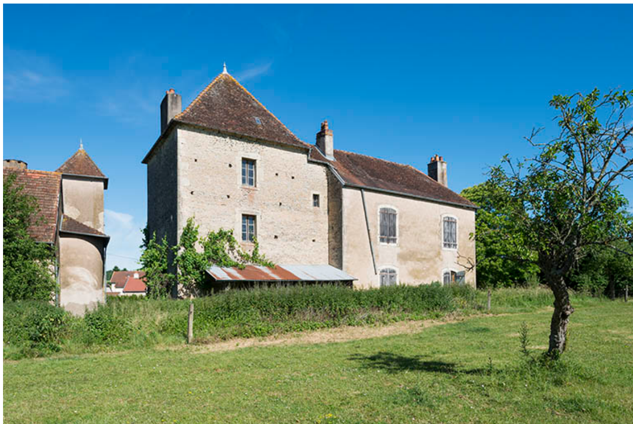
La façade postérieure du bâtiment XVIIIe.
