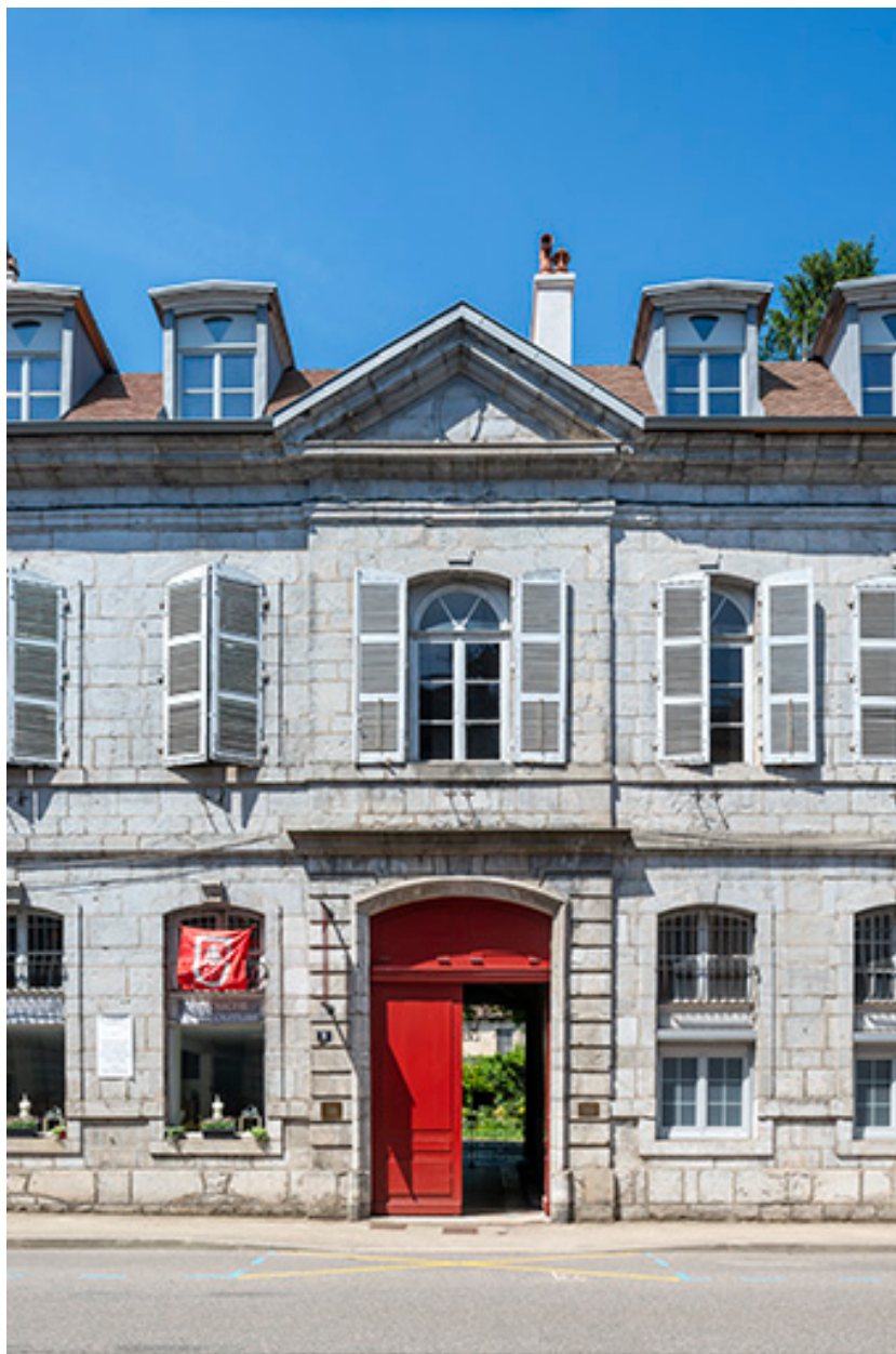
Façade antérieure. Travées centrales.
