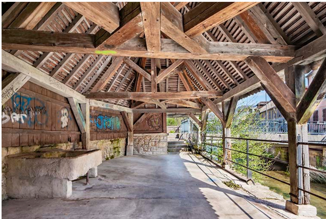
Vue de la charpente, depuis le sud.
