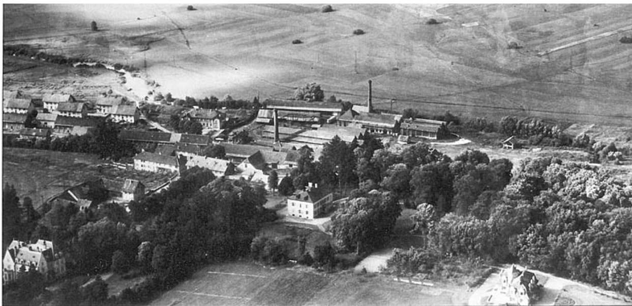
Vue aérienne des forges de Morvillars vers 1960.
