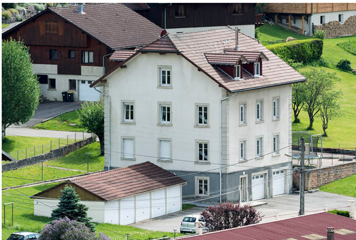
Façades postérieure et latérale gauche.
