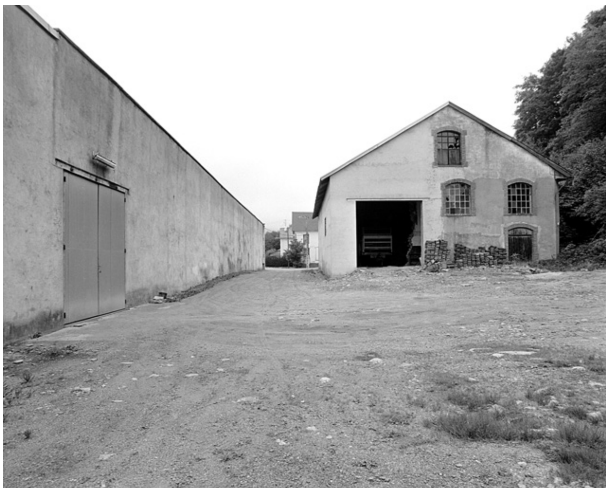
Façade postérieure de la salle des machines.
