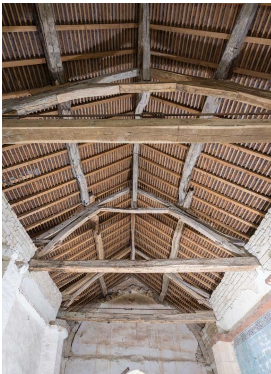
La charpente de la nef.
