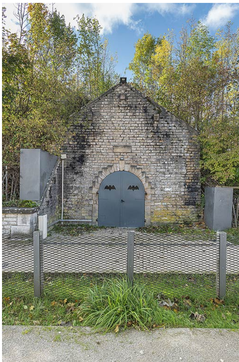
Site de l'ancien arsenal : magasin à poudre V1, vue de face.
