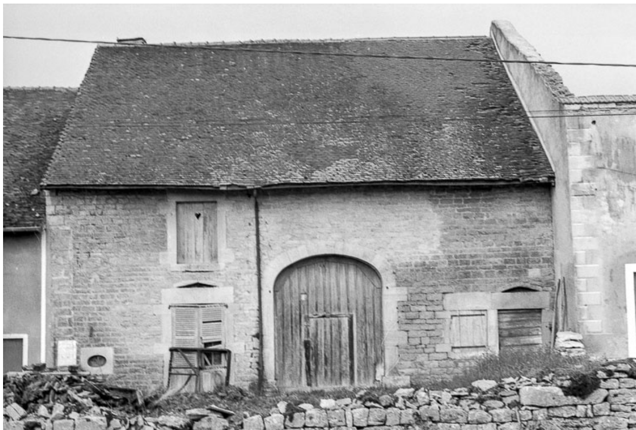
Ferme cadastrée B2 134 : façade postérieure (?).
