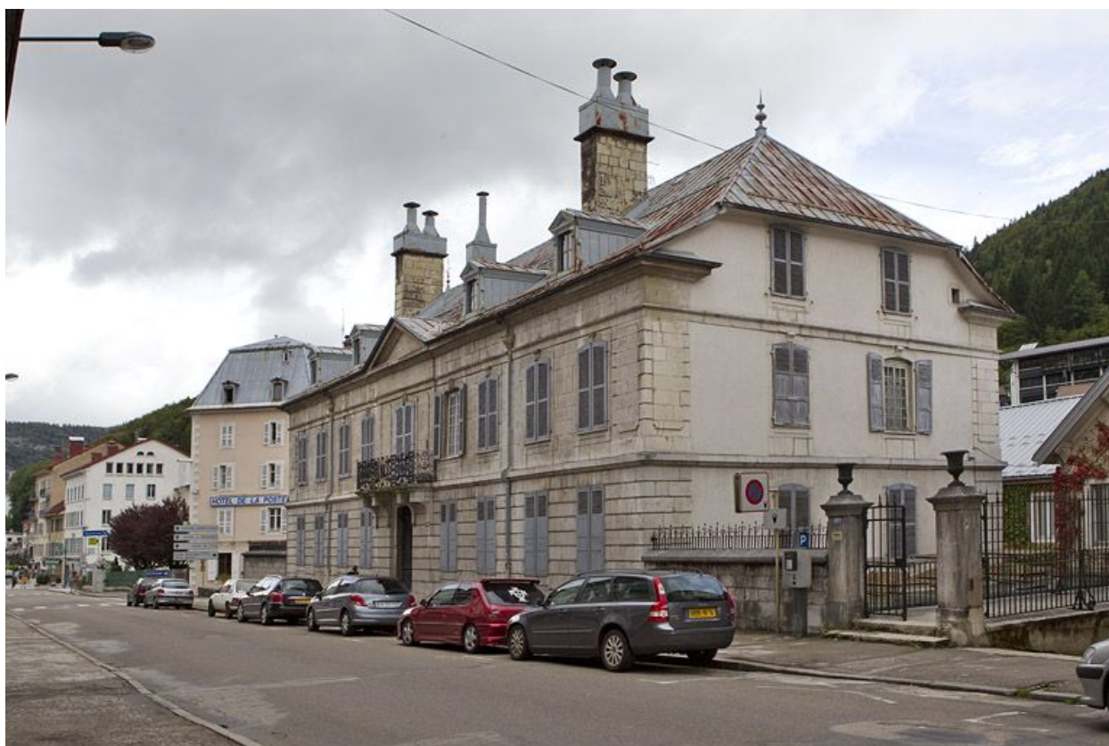
Façade du logement patronal, sur la rue.
