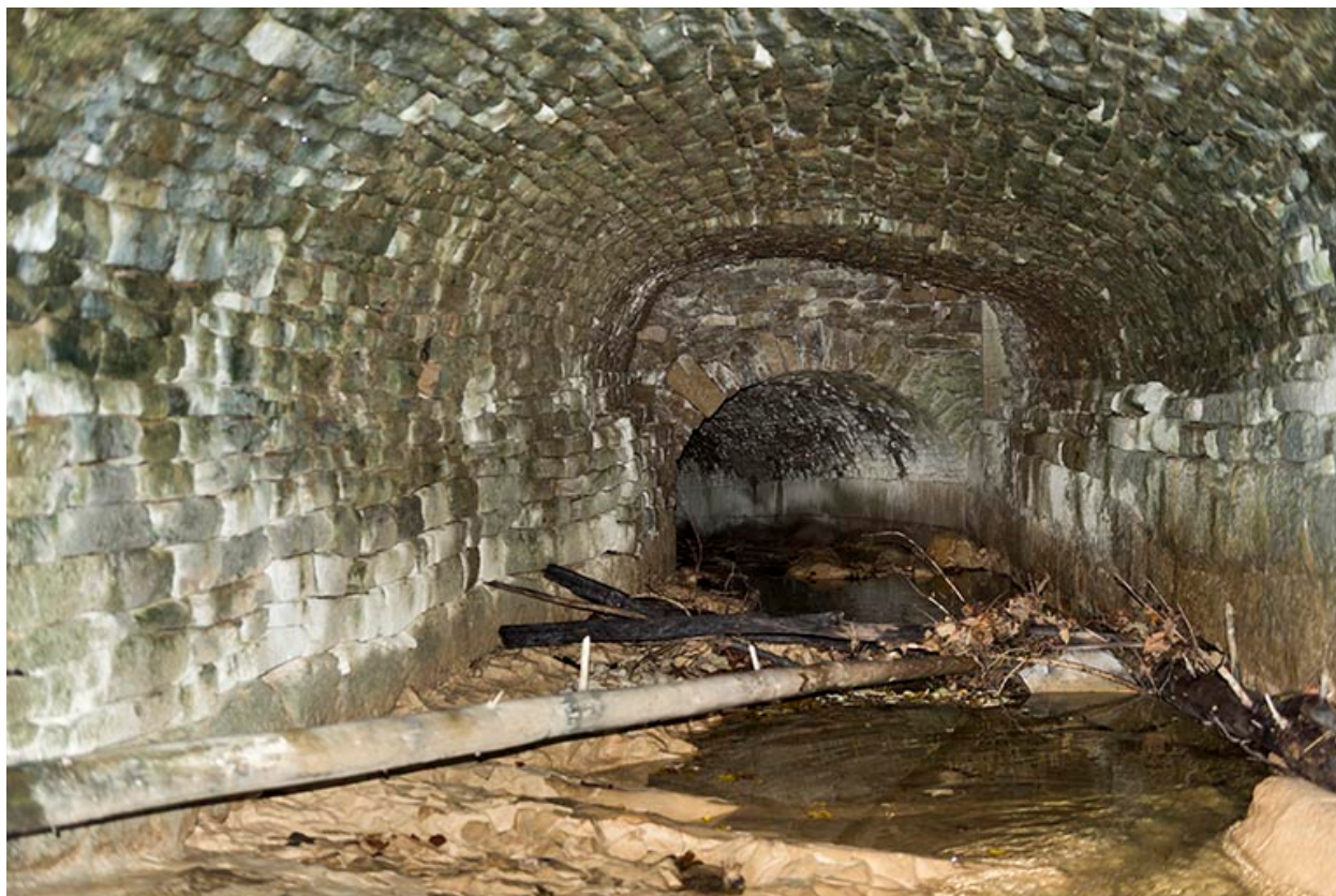
Voûte sur le ruisseau couvert.
