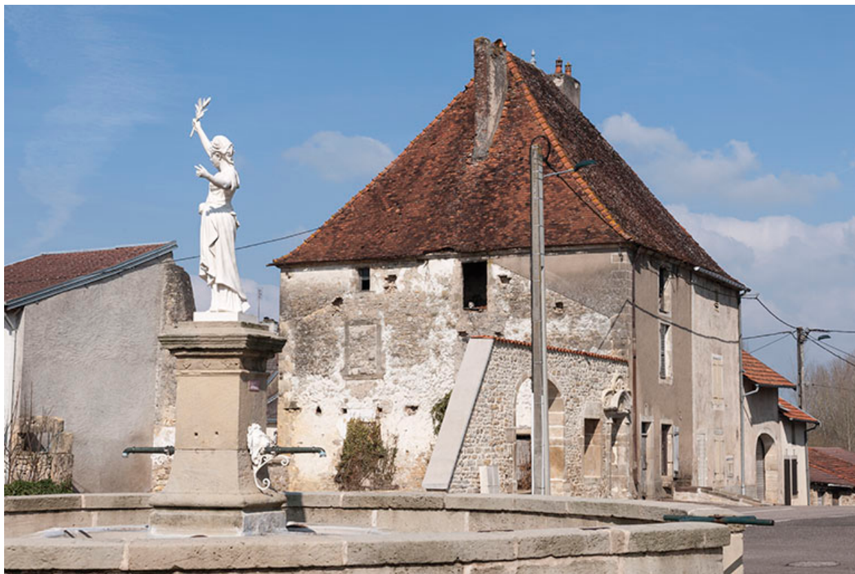
La fontaine et l'ancien presbytère.
