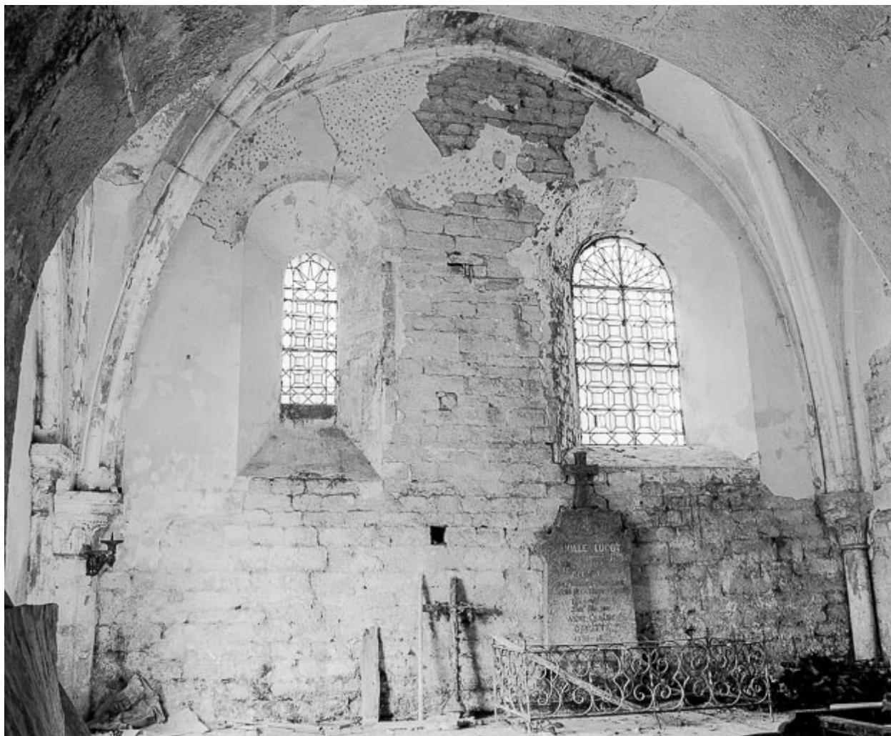
Intérieur : mur latéral gauche.
