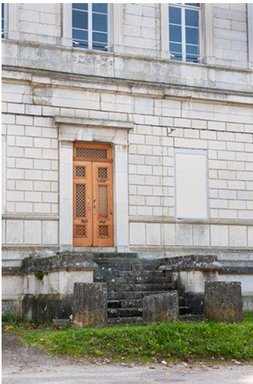
Porte de la façade nord
