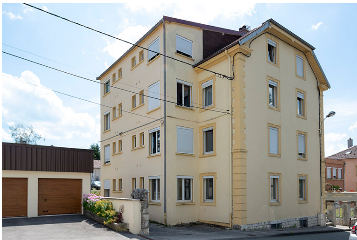
Façades postérieure et latérale gauche.
