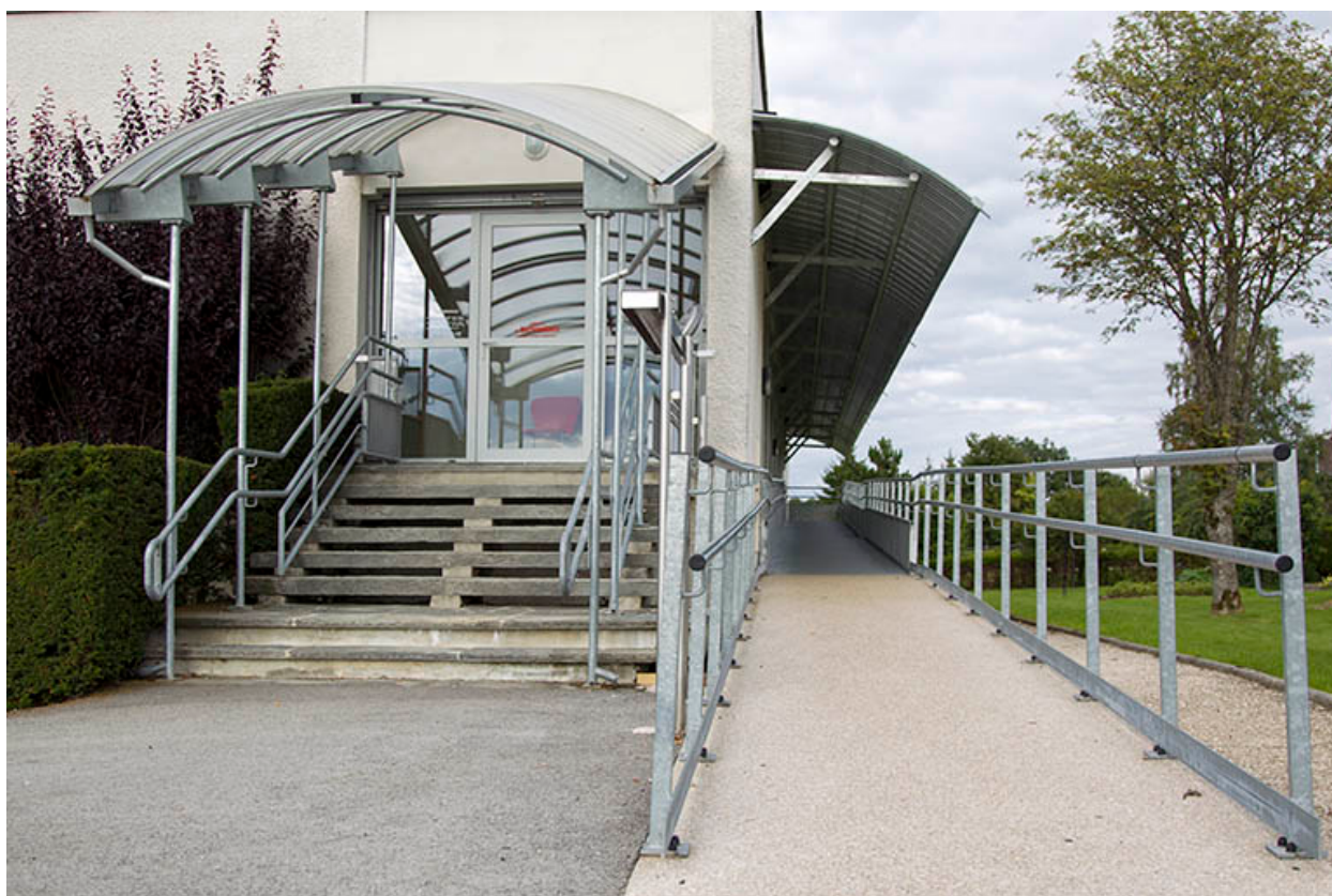
Façade latérale droite : escalier et rampe d'accès.
