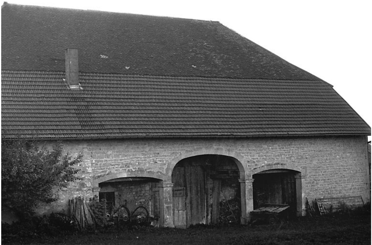
Vue du mur gouttereau droit.
