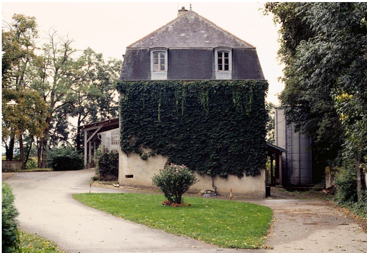
Façade latérale depuis le nord.
