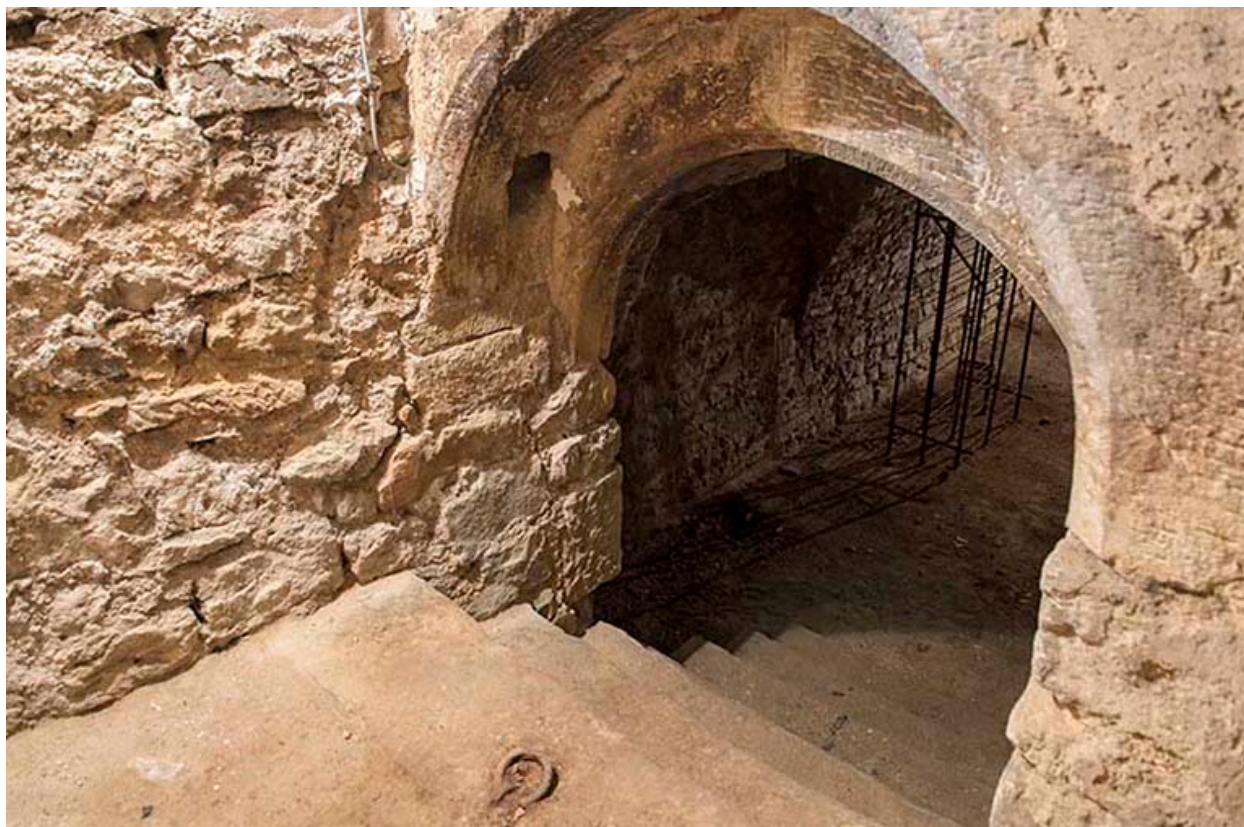
Détail de la descente de cave.
