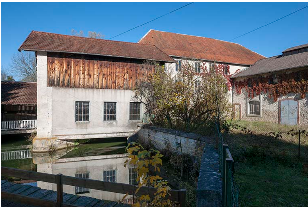
Bâtiment d'eau et atelier de fabrication.
