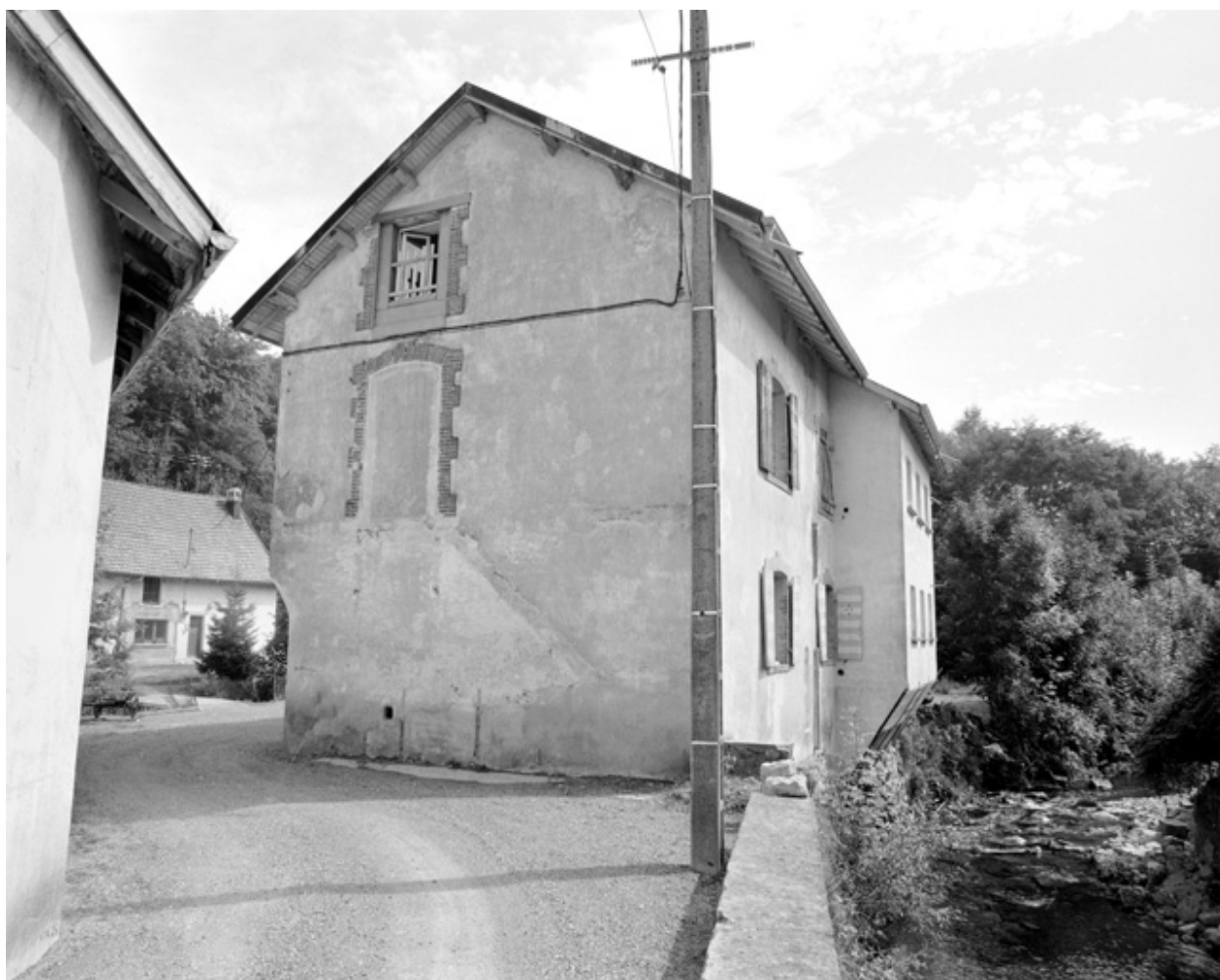
Logement d'ouvriers sur la rivière.
