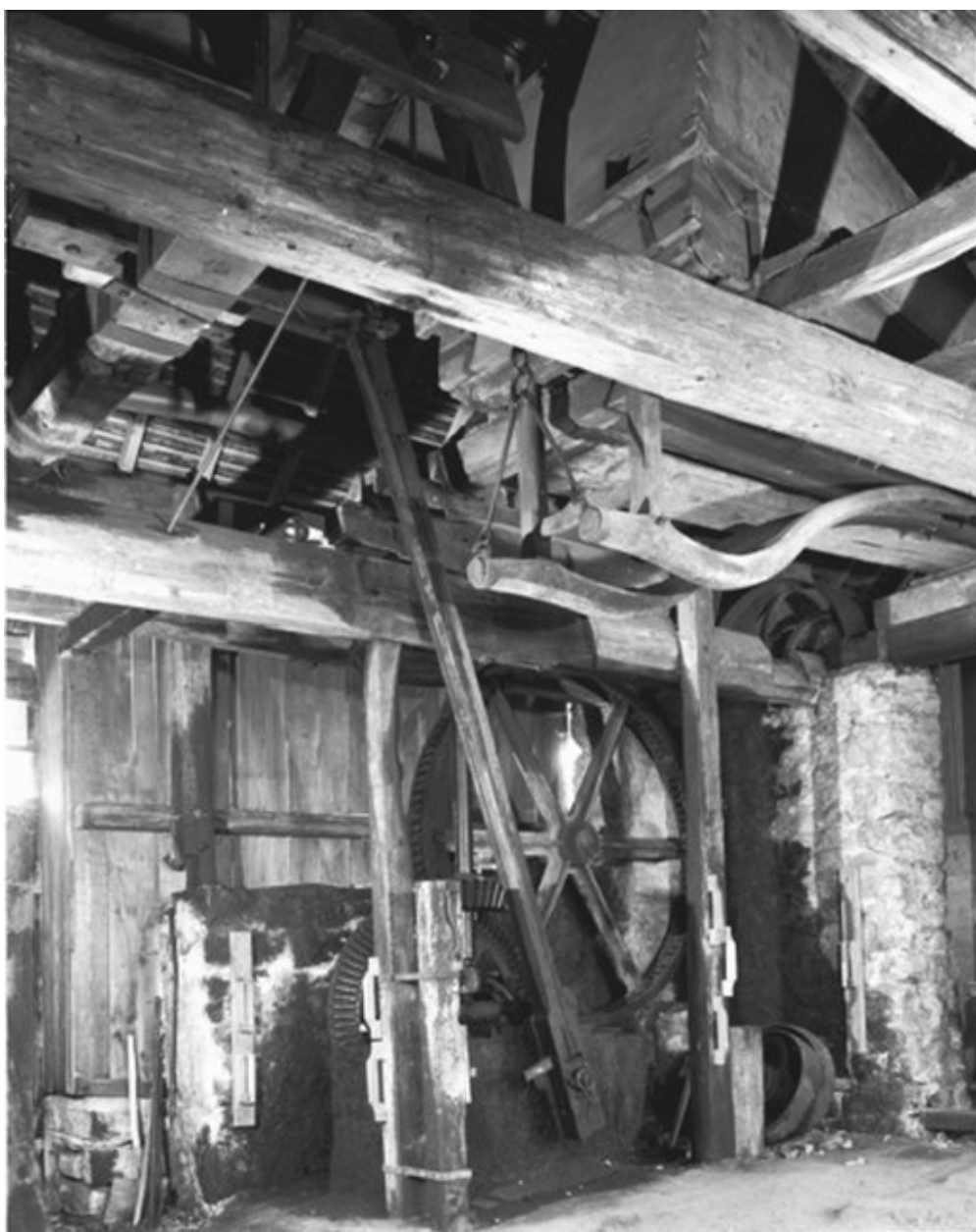
Vue rapprochée des mécanismes et des soufflets.
