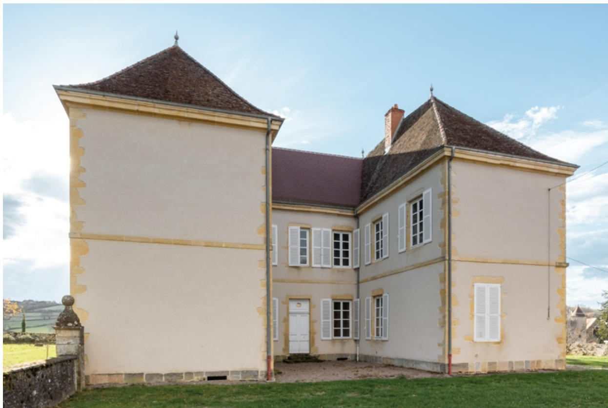
Façade nord-est du château
