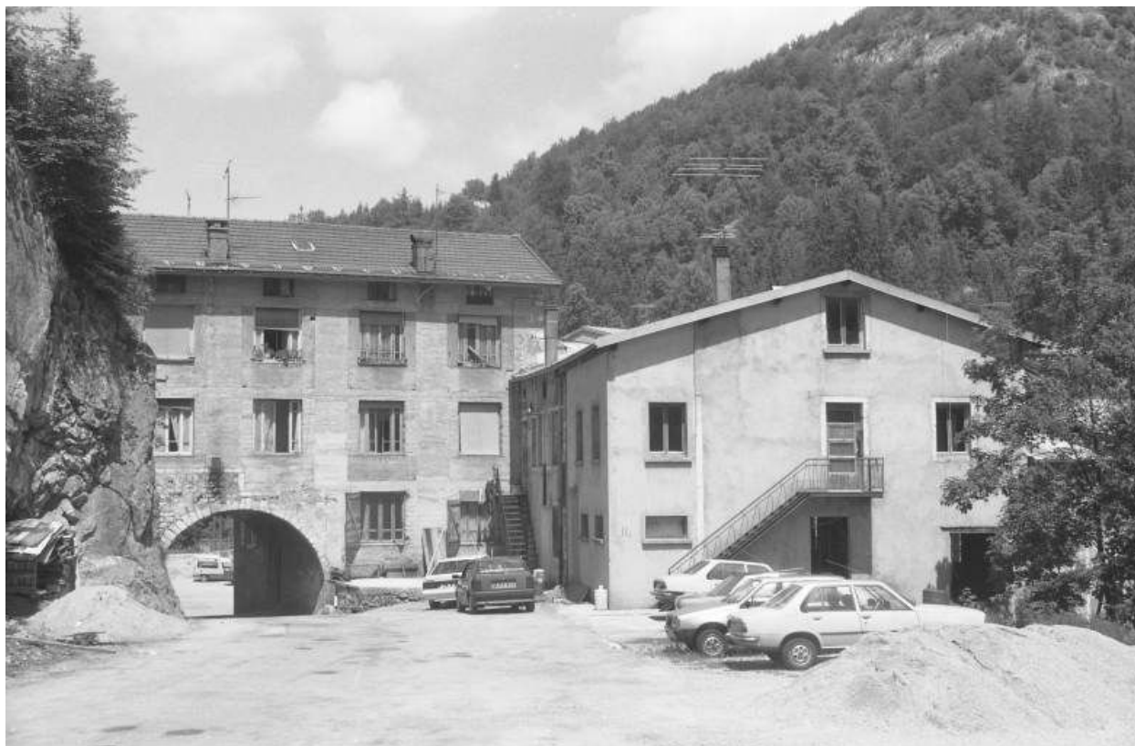
Vue d'ensemble depuis le sud-est (amont).
