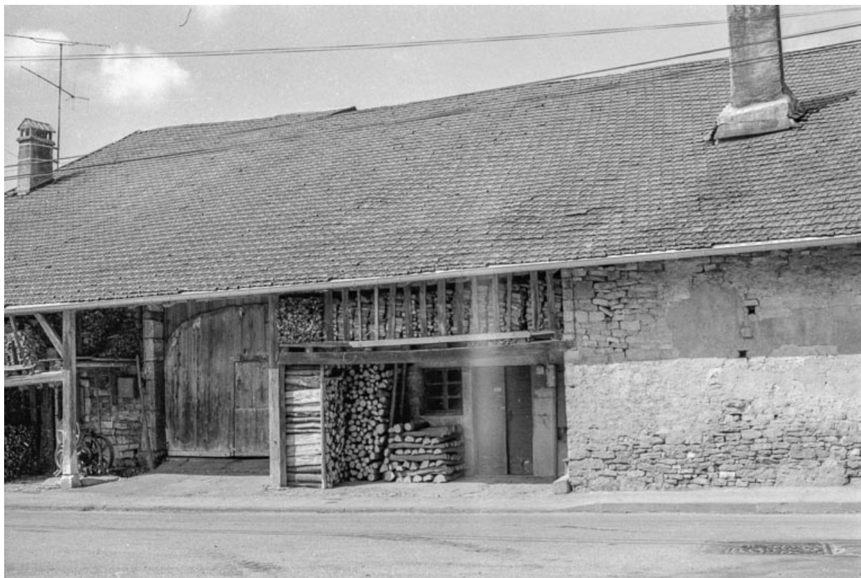
Détail de la façade sur rue.
