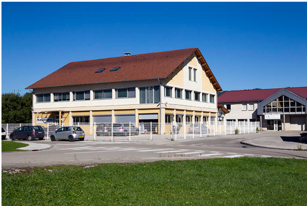
Façades antérieure et latérale droite.
