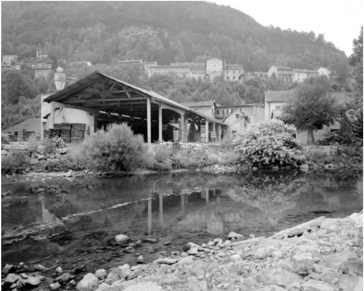
Magasins industriels depuis la rive droite de la Bienne.
