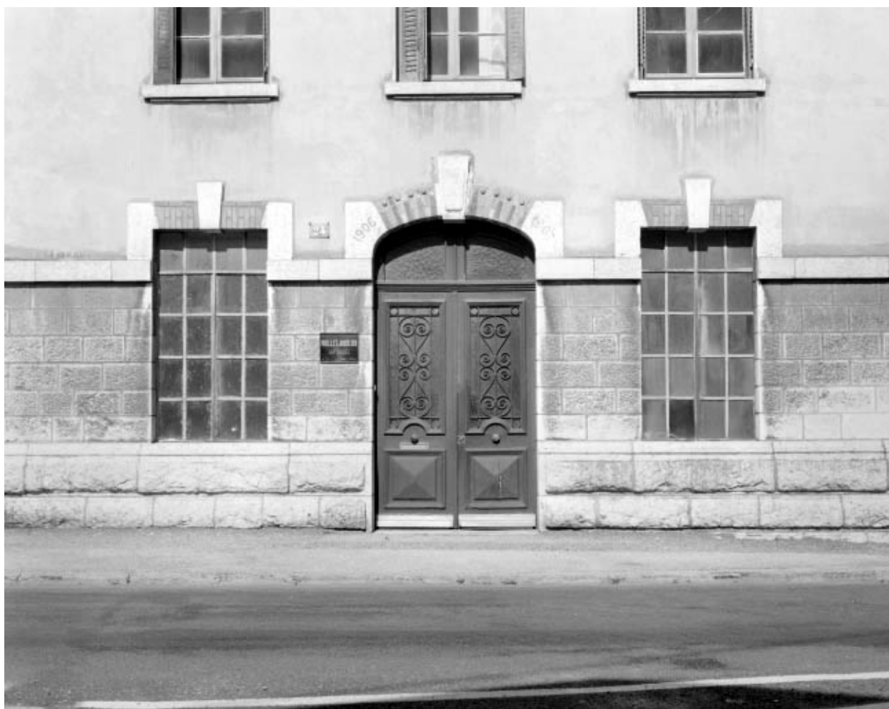
Entrée du 1er bâtiment.
