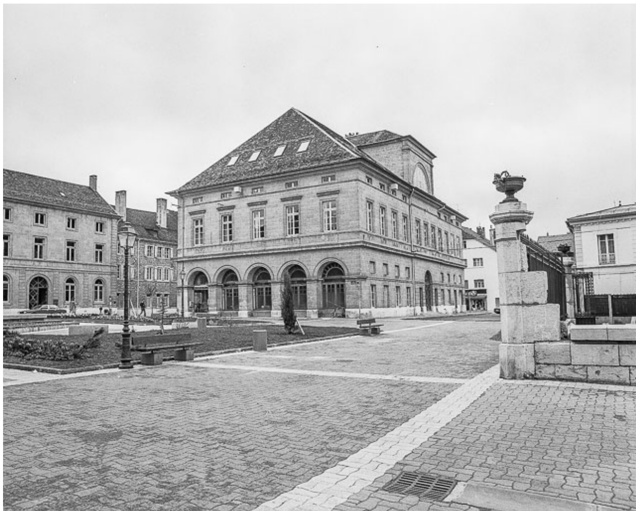
Façade postérieure et façade latérale droite.
