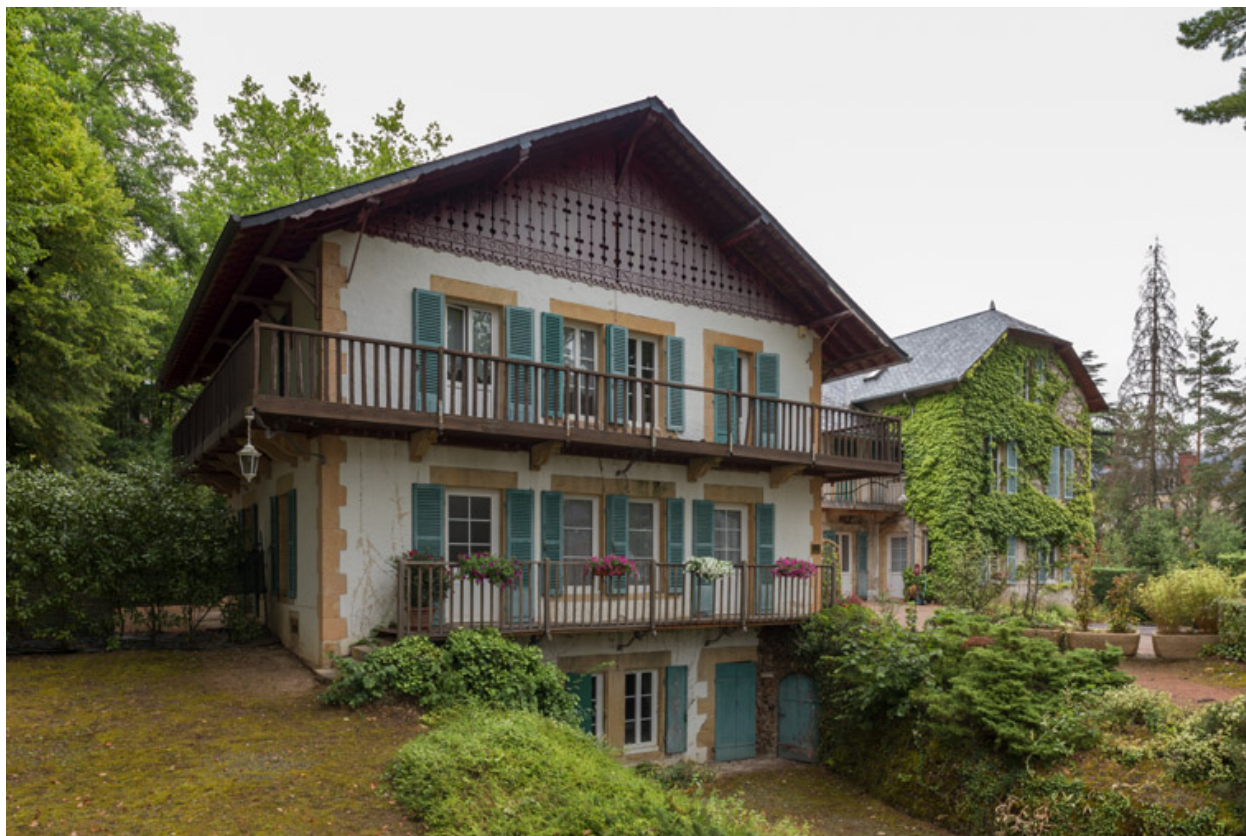
Façade du corps principal, vue de trois-quarts.
