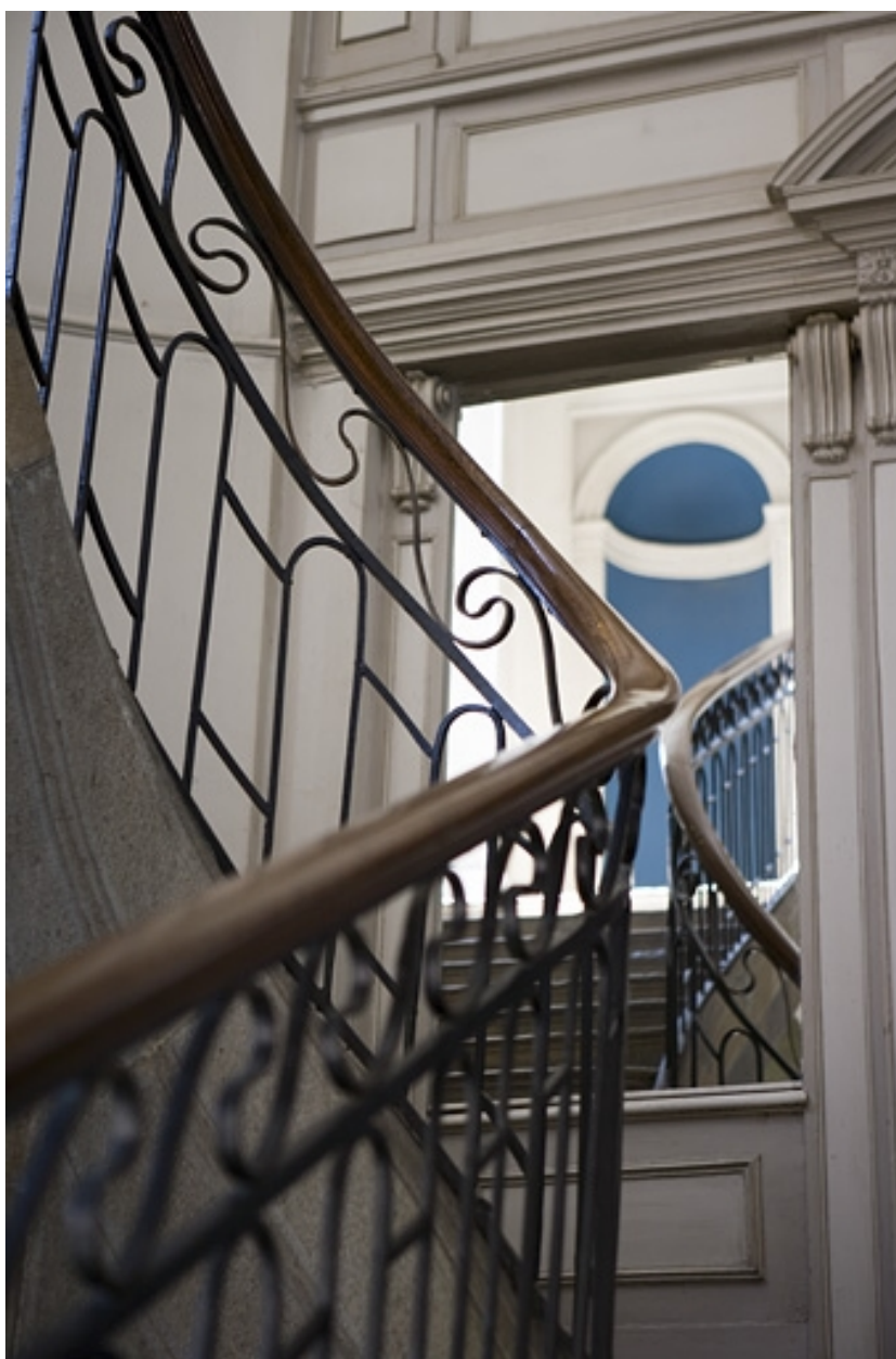
Détail de la rampe de l'escalier d'honneur.
