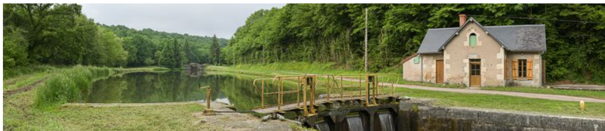
Vue d'ensemble du site d'écluse.
