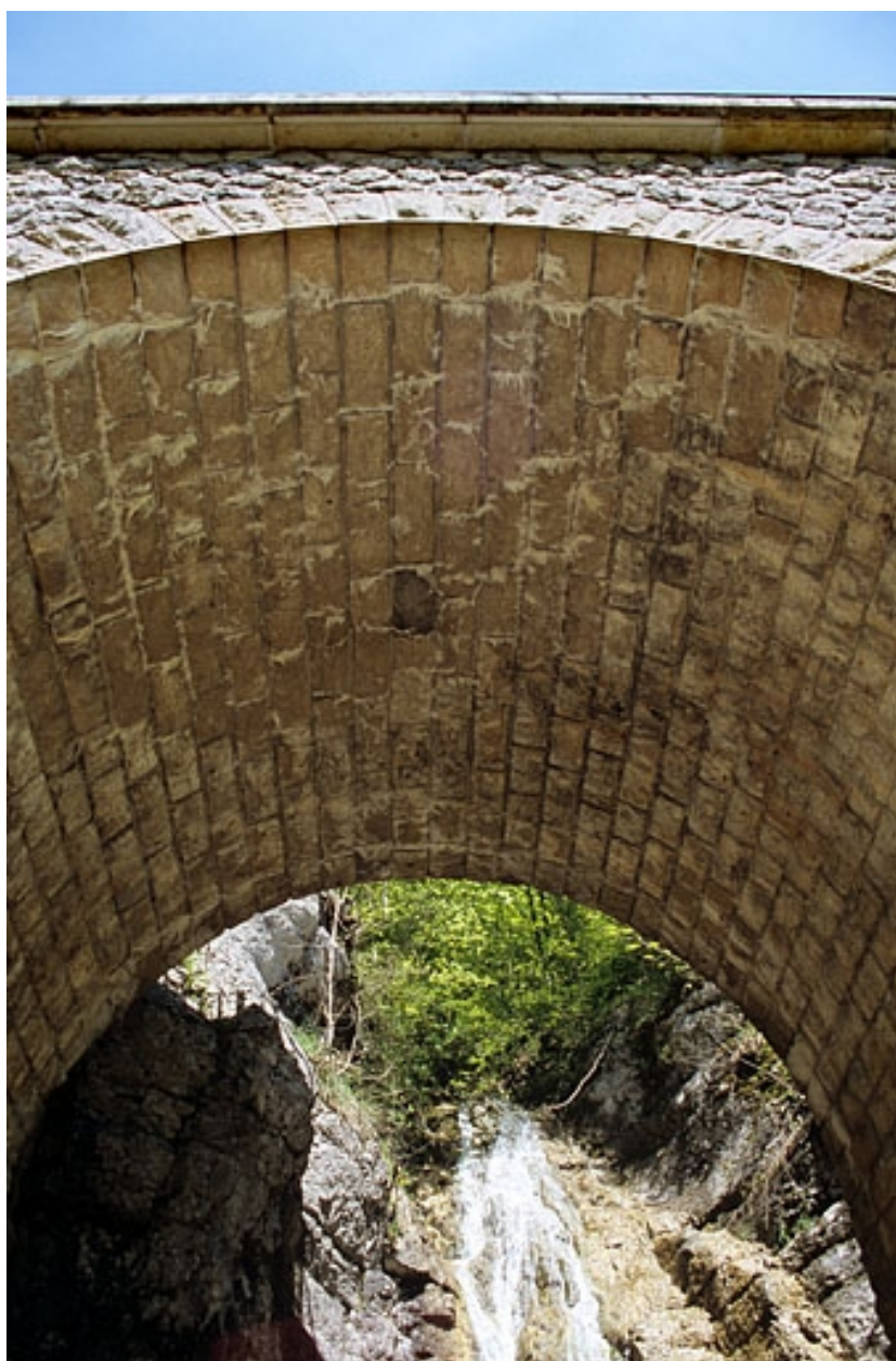
Viaduc : arche, vue du dessous.
